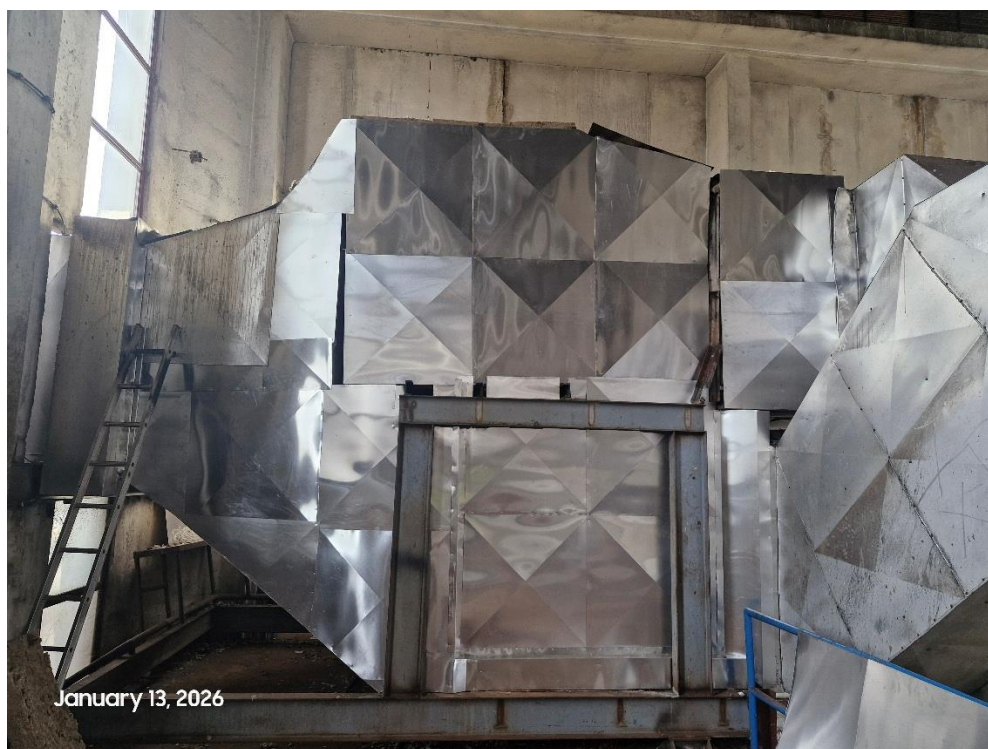
Slika br. 4 - Ekonomajzeri nakon rekonstrukcije – Umka Figure 4. Economizers after reconstruction — Umka.
