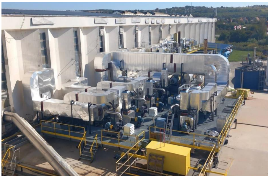
Slika 6: Deo sistema za sušenje premaza smešten van hale karton mašine
