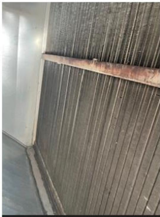
Figure 11. Improved air flow with cleaning of the plugged filter for the supply air V2906 Slika 11. Poboljšán protok vazduha nakon čišćenja začepljenog filtera za dovodni vazduh V2906
